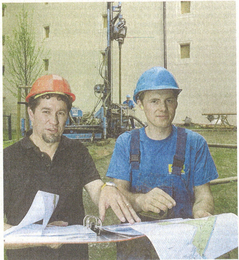
Rüdiger Grimm (l.), Chef der Firma Geoenergie Konzept, und Sören Philipp arbeiten bei den Bohrungen Hand in Hand.
